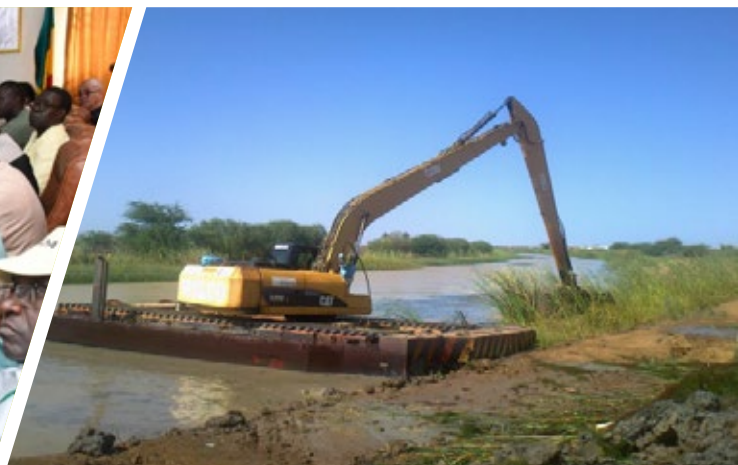
Image travaux d'entretien d'un axe hydraulique
