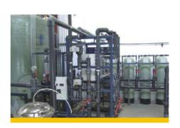
处理规模(Treatment scale): 20m³/h 出水水质(Water quality): ≥18MΩ · cm (25℃) 主体工艺(Main process): 如下as follows)
