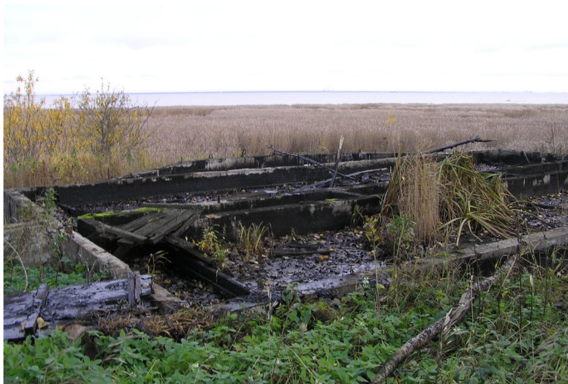
Рис. 5. Отработанные смазочные масла, слитые в подвал разрушенного дома, на берегу Финского залива.
