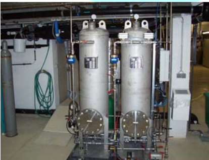
Abbildung: Filtersysteme ausgelegt auf einen Durchfluss von 1 l/s und 50 l/s.
