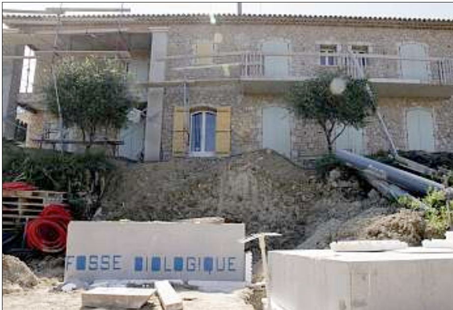
Les quatre fosses septiques, en béton armé, sont enterrées. Elles reposent sur du sable et des poutrelles pour davantage de stabilité. (Photo Grégoire Albertini)
