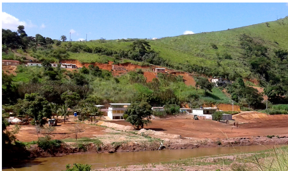
Figura 16: Preparo do solo e plantio em matas ciliares. Nota-se a diferença de coloração entre o solo impactado pelo rejeito e aquele que foi alocado para a mata ciliar, a utilização de técnicas de drenagem e a presença de maquinários utilizados no preparo do solo. Também é possível perceber a presença de uma área em cujo plantio não foi bem sucedido.
